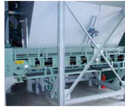
③ 肥料搬送コンベヤ
