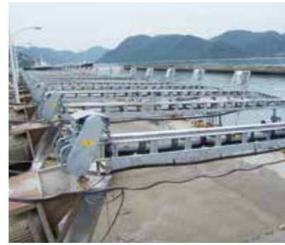
② かき搬送コンベヤ
