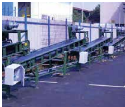
⑦ 土砂搬送コンベヤ (エアーマータ)
