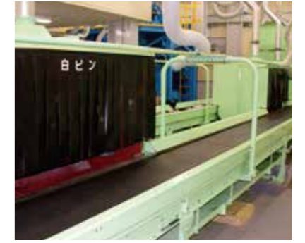
3 ペットボトル搬送コンベヤ
