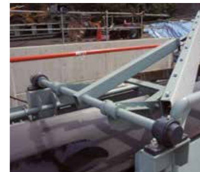
11 中間払出装置
