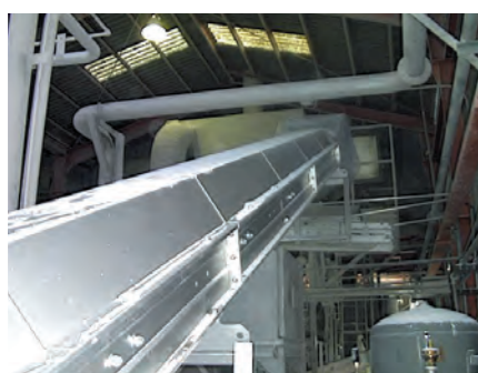
舟底型 石灰搬送コンベヤ
