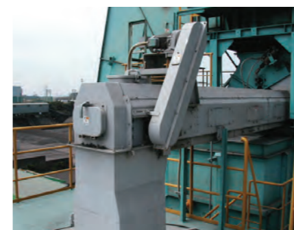
舟底型 土壌改良設備 投入コンベヤ
